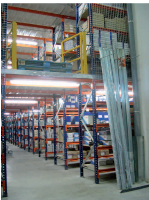
Almacén distribuidor de material eléctrico.
